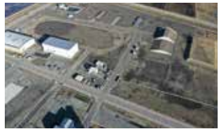
⑩ 瓦礫・土砂崩落フィールド
