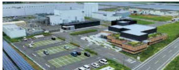
福島水素エネルギー研究フィールド
