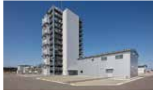
④ 試験用プラント・試験準備棟
